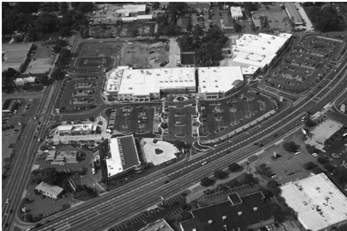
Рис.2. Строительная площадка Abercorn с высоты 150 метров.
