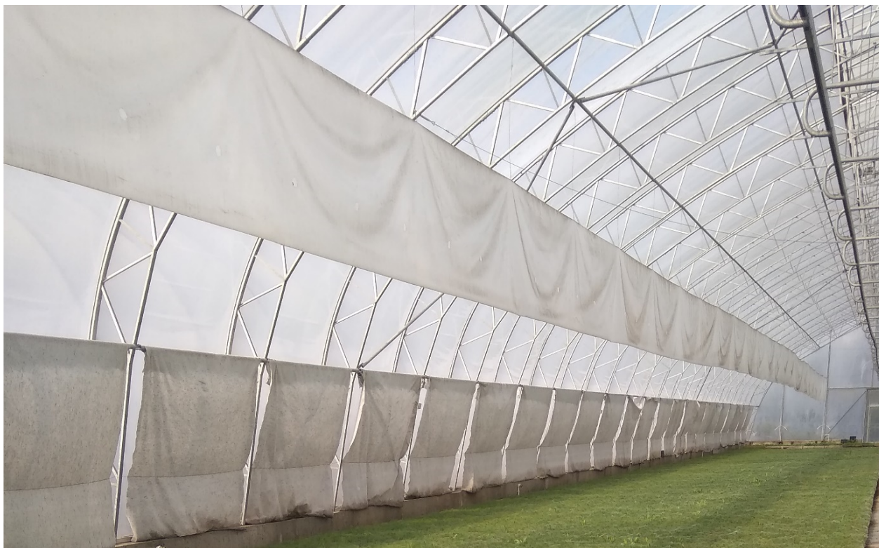
Рисунок 10. Работа системы занавесов, формирование искусственного притенения
