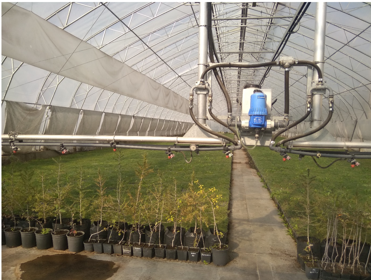
Рисунок 2. Поливная система тепличного комплекса
